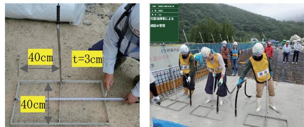
写真-2 締固め定規
