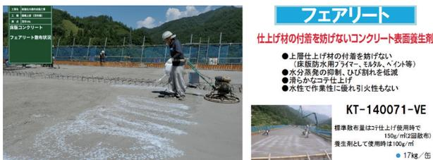
写真-8 表面養生剤散布状況
