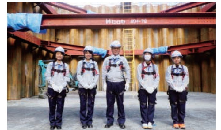
豊能廃棄物施設設置工事
