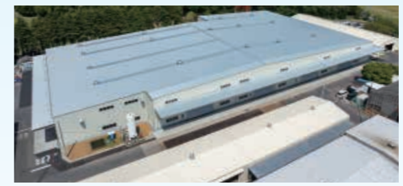
(仮称)千葉第一工場建替工事(千葉県)
