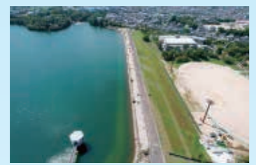
三好池堤体耐震補強工事(愛知県)
