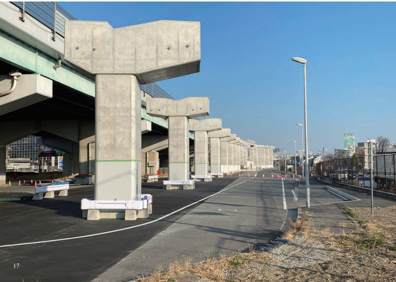
大阪モノレール 支柱建設工事(三島工区その1)(大阪府)
