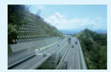
新名神高速道路原東工事(大阪府)
