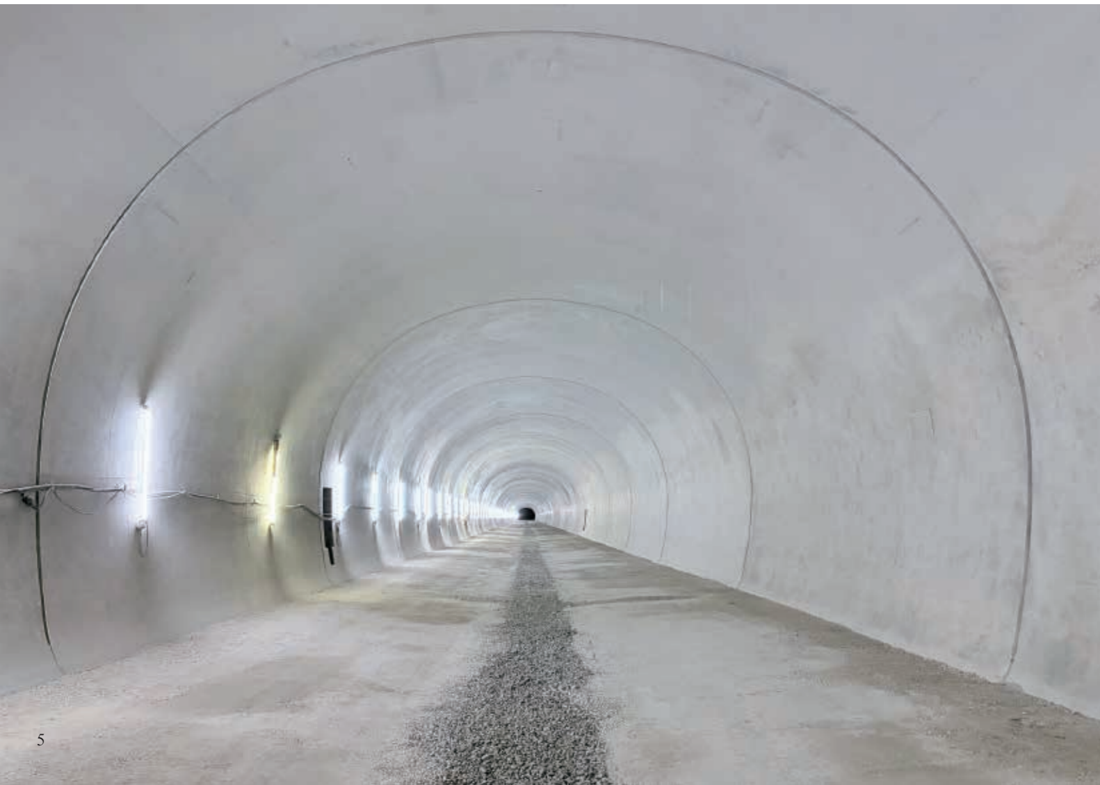
国道429号 榎峠バイパス 榎峠トンネル(仮称)建設工事(兵庫県)
