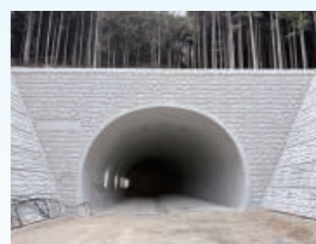
国道429号 榎峠バイパス 榎峠トンネル(仮称) 建設工事 (兵庫県)
