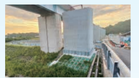
阪和自動車道 切目川橋(下部工)工事(和歌山県)
