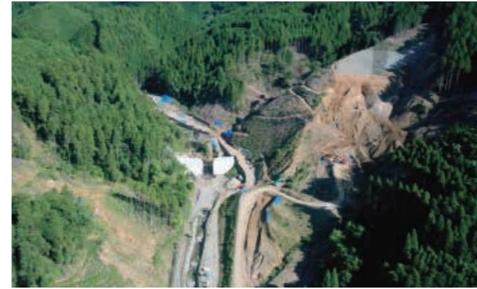
乙石川上流砂防堰堤工事(福岡県)
