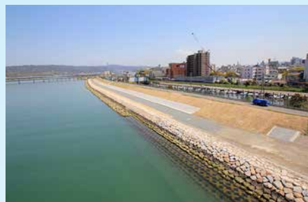
紀の川湊紺屋町地区堤防強化工事(和歌山県)
