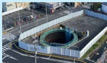
寝屋川流域下水道 枚岡河内中央増補幹線立坑築造工事(R5-1)(大阪府)
