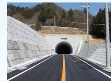
山野部坂トンネル建設工事(兵庫県)
