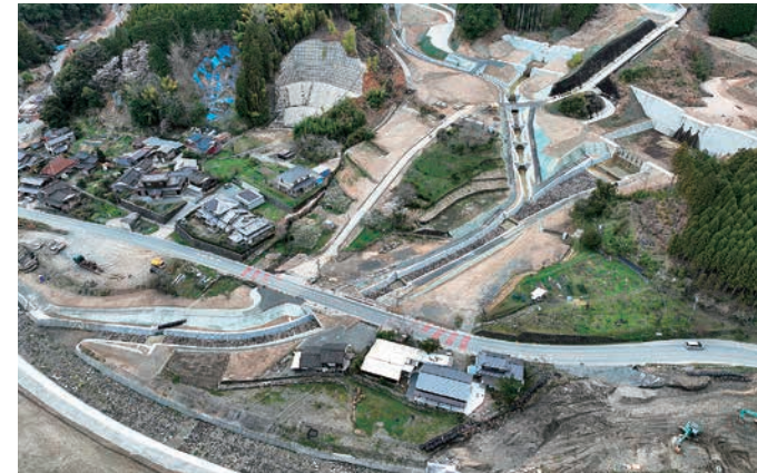
令和3年度赤谷川16溪流保全工事（福岡県）
