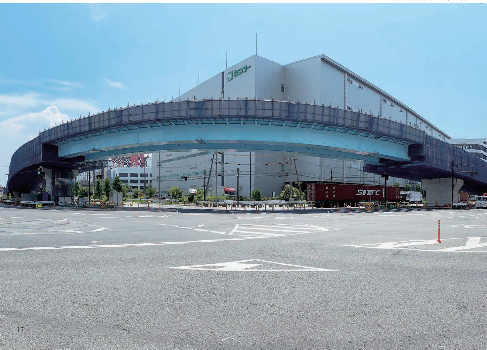
舞洲東高架橋架設工事(大阪府)
