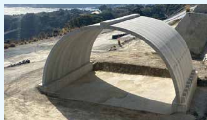
すさみ串本道路里野西地区改良工事(和歌山県)
