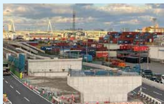
(仮称)夢洲北高架橋架設工事-1(大阪府)
