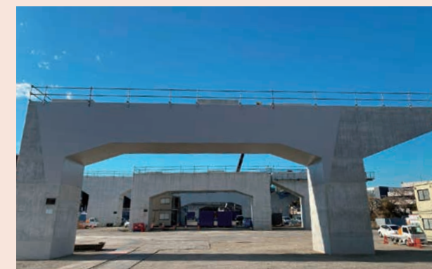
R4横環南米IC・JCT下部その1工事(神奈川県)
