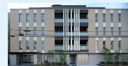
シオ南武庫之荘WEST新築工事(兵庫県)
