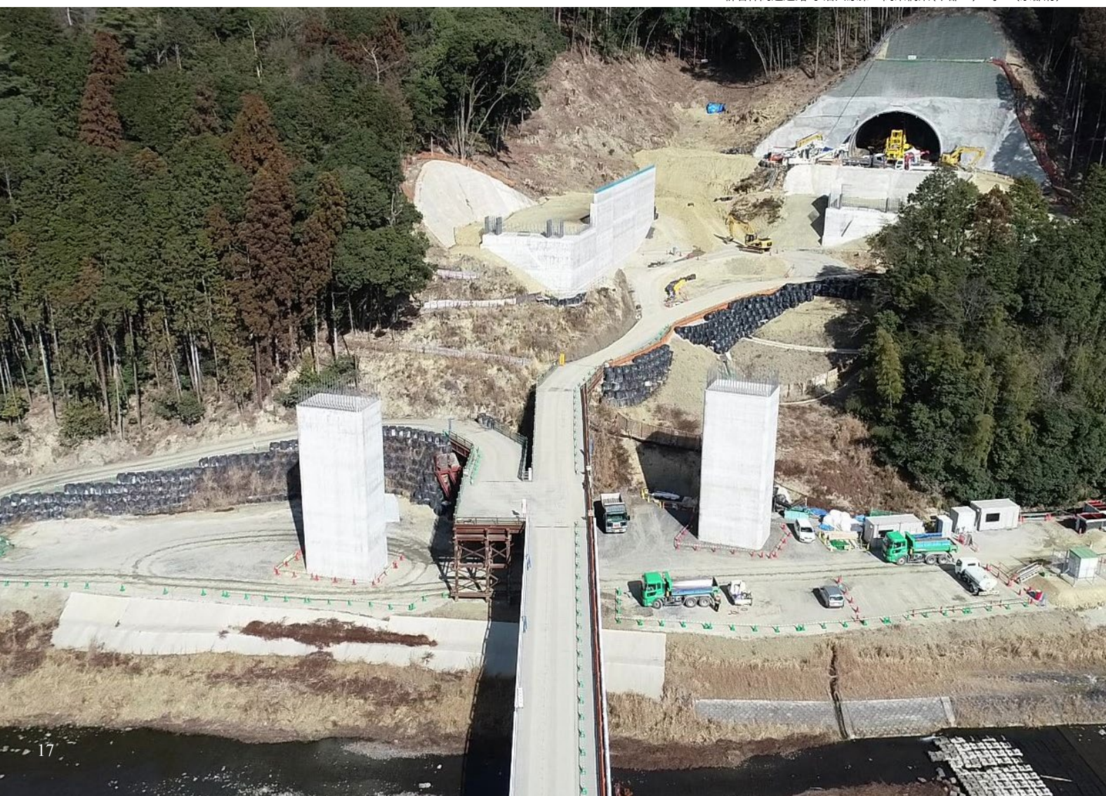
新名神高速道路 宇治田原第二高架橋東(下部工)工事 (京都府)
