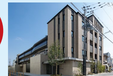
シオ樟葉新築工事(大阪府)
