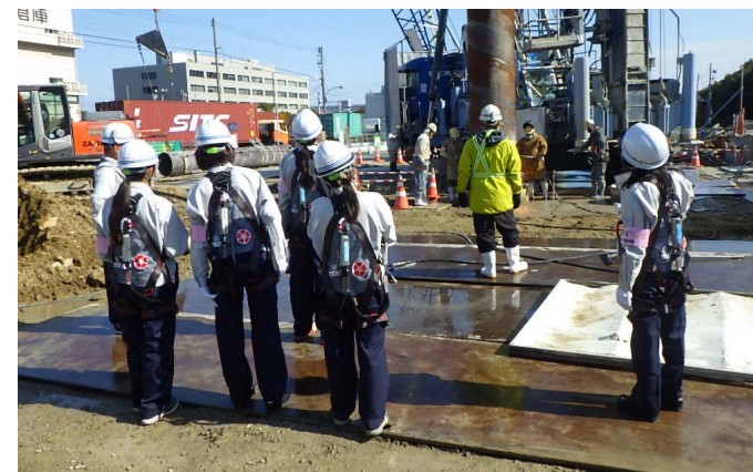
大阪湾岸道路西伸部六甲アイランド第3高架橋 PE5他下部工事（兵庫県）
