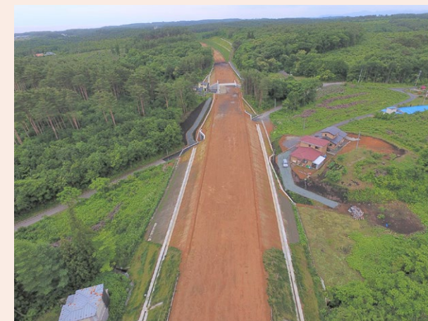
城内地区道路改良工事(岩手県)
