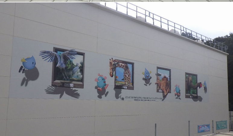
東村山市青葉町一丁目地内から新座市新堀二丁目地先間原水連絡管 (2000mm)トンネル内配管及び立坑築造工事(東京都) 隣接している保育園の園児に喜んでもらえるよう防音ハウス壁面へのフォトリックアート掲示 しました。(縦3m×横20m)
