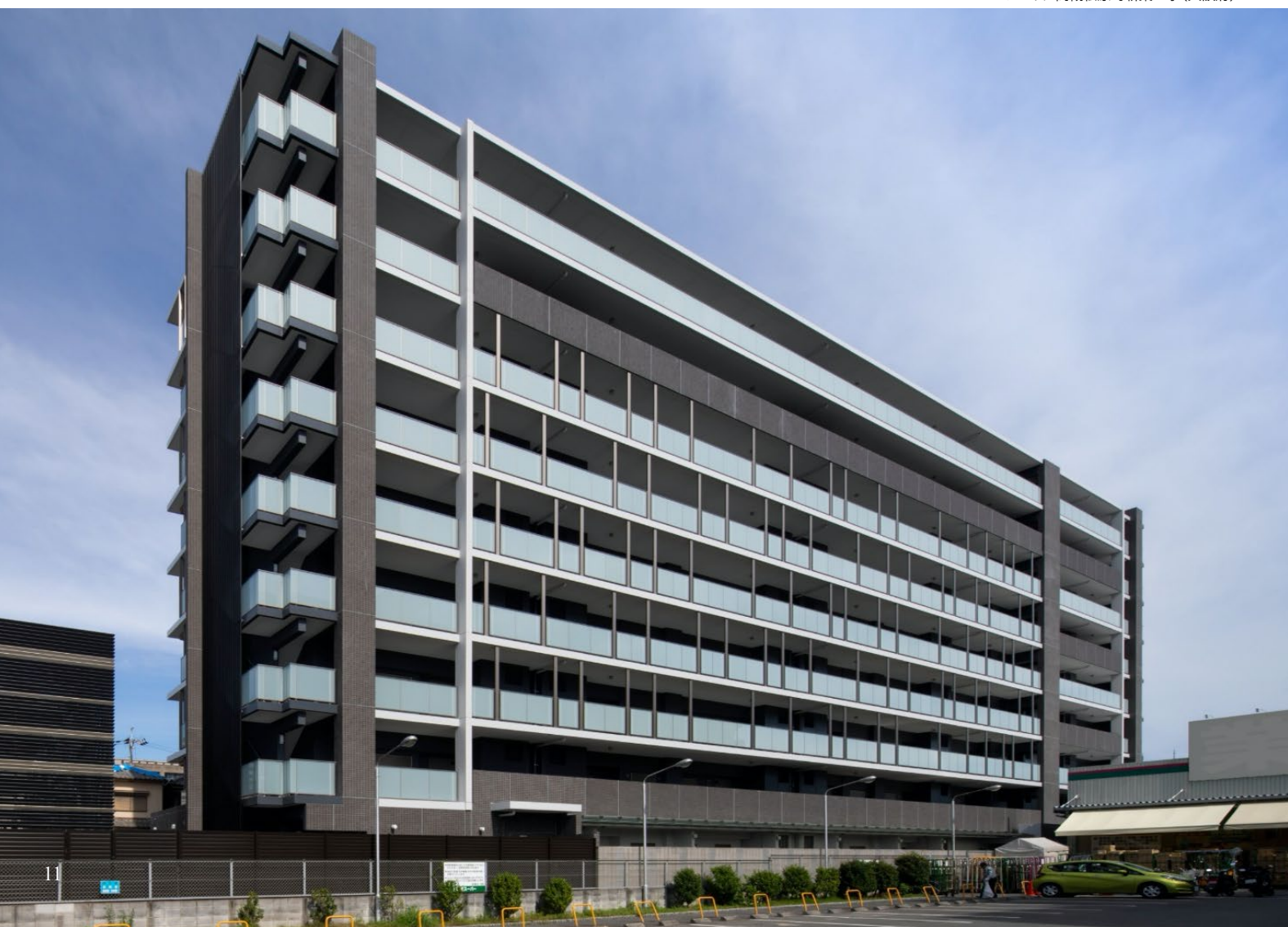
シエリア高槻松原町新築工事(大阪府)
