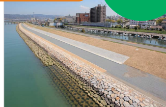
湊紺屋町地区堤防強化 (和歌山県) ▲
