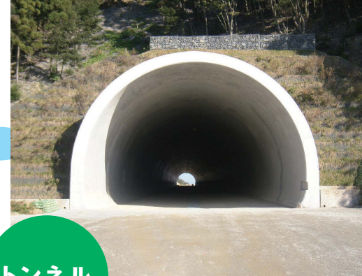
舞鶴若狭道 気山トンネル (福井県) ▲
