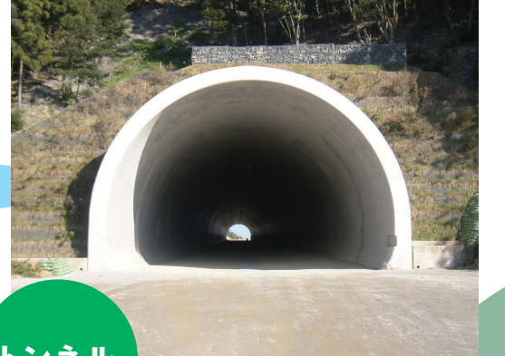
舞鶴若狭道 気山トンネル (福井県) ▲
