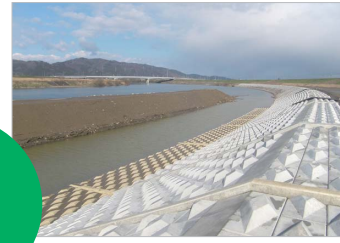
中角低水護岸 (福井県) ▲
