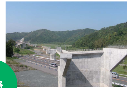
舞鶴若狭道 気山高架橋 (福井県) ▲
