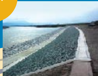
吉野川瀬部護岸復旧工事 (徳島県) ▲
