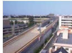
阪急電鉄神戸線 武庫川橋梁改築工事 (兵庫県)
