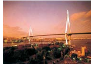
▲ 阪神高速湾岸線安治川橋 (大阪府)
